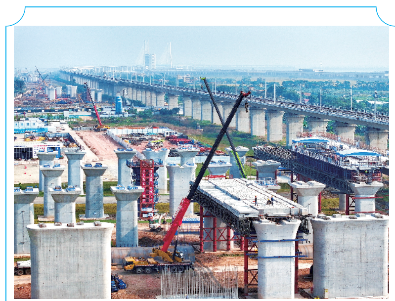
深江铁路南沙站进入现浇梁施工
