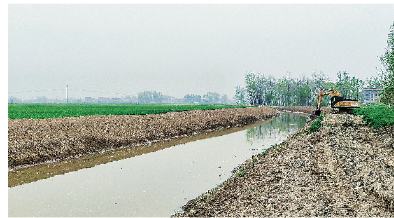
近年来,我市持续强化农田水利基础设施建设,为保障粮食安全、推动农业现代化提供了重要支撑。图为4月10日,淮阳区郝集乡利用大型机械对运粮河段进行疏淤修整。 记者 刘俊涛 摄
